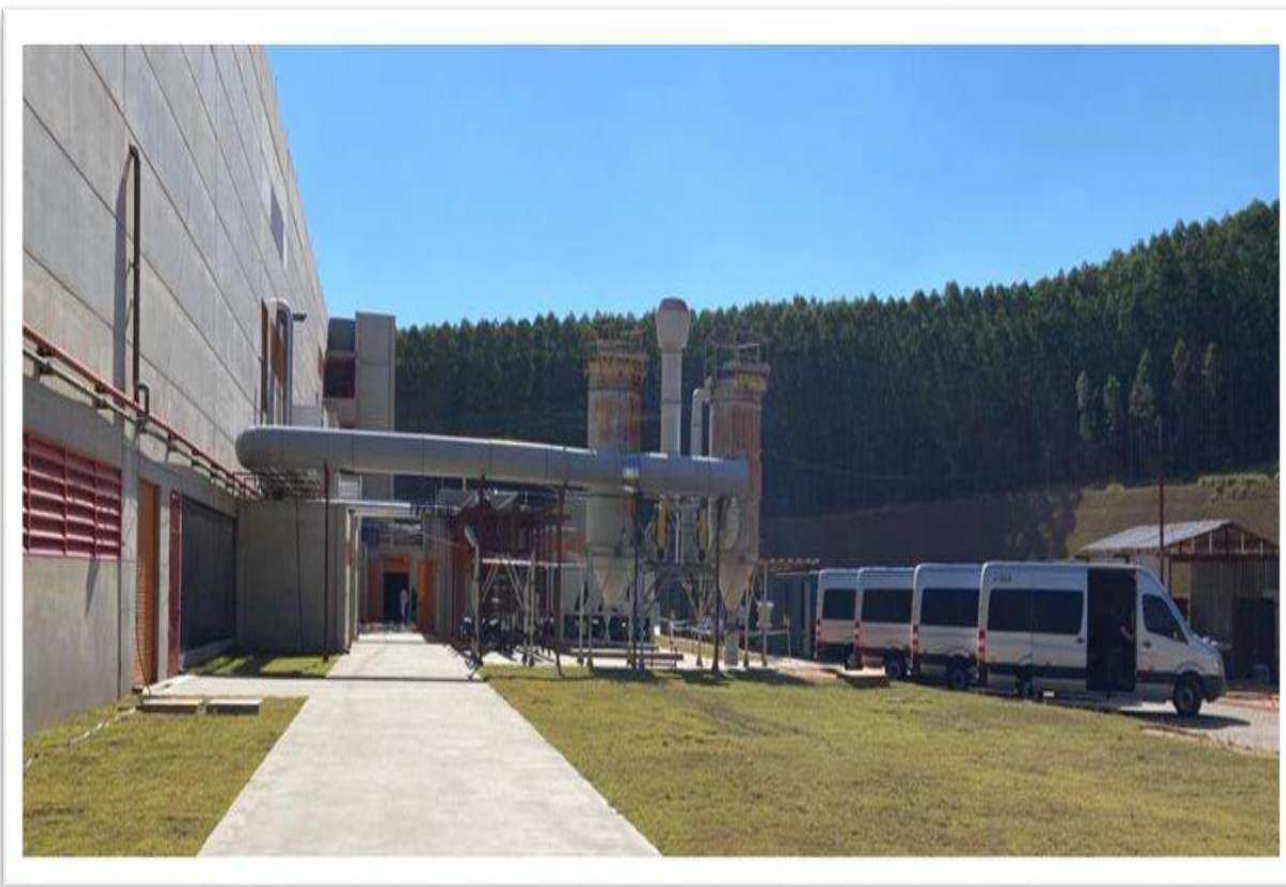
Parque fabril – área externa do setor de utilidades.
